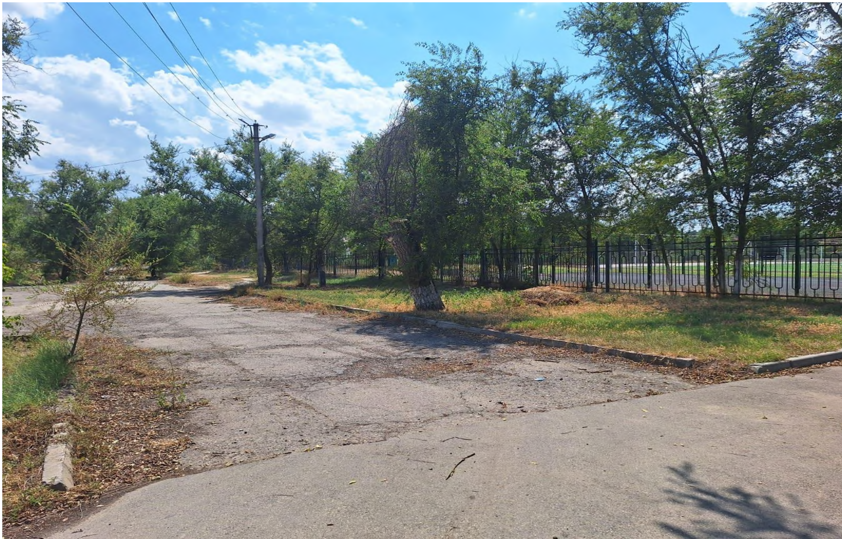
ФОТОФИКСАЦИЯ СУЩЕСТВУЮЩЕГО СОСТОЯНИЯ ТЕРРИТОРИИ
